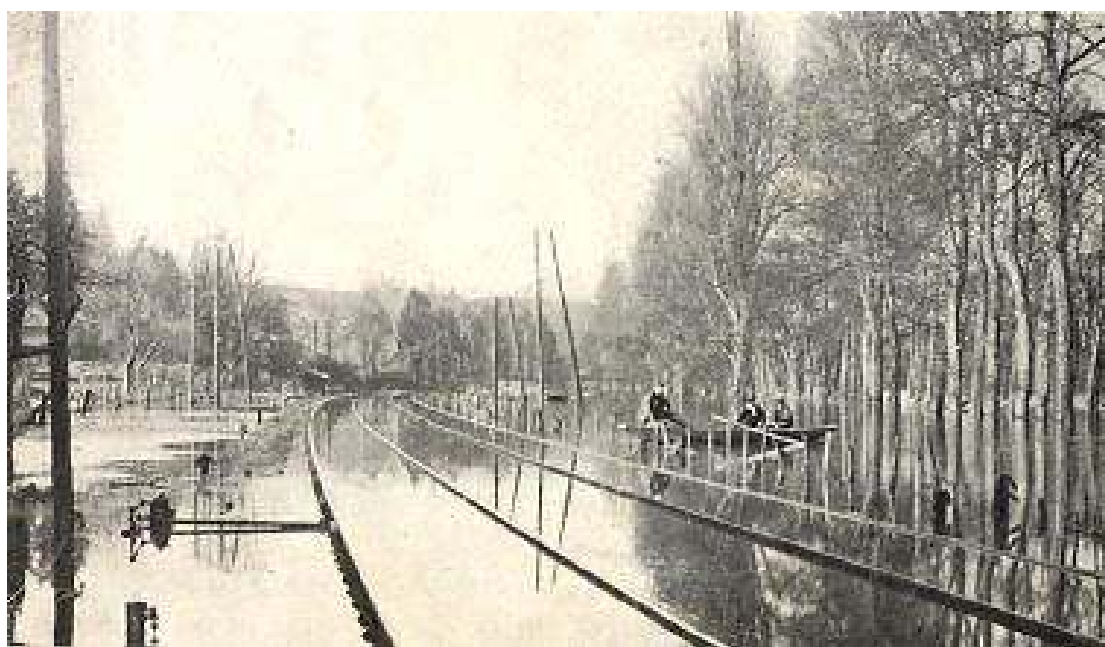
Villennes-sur-Seine : voie SNCF
