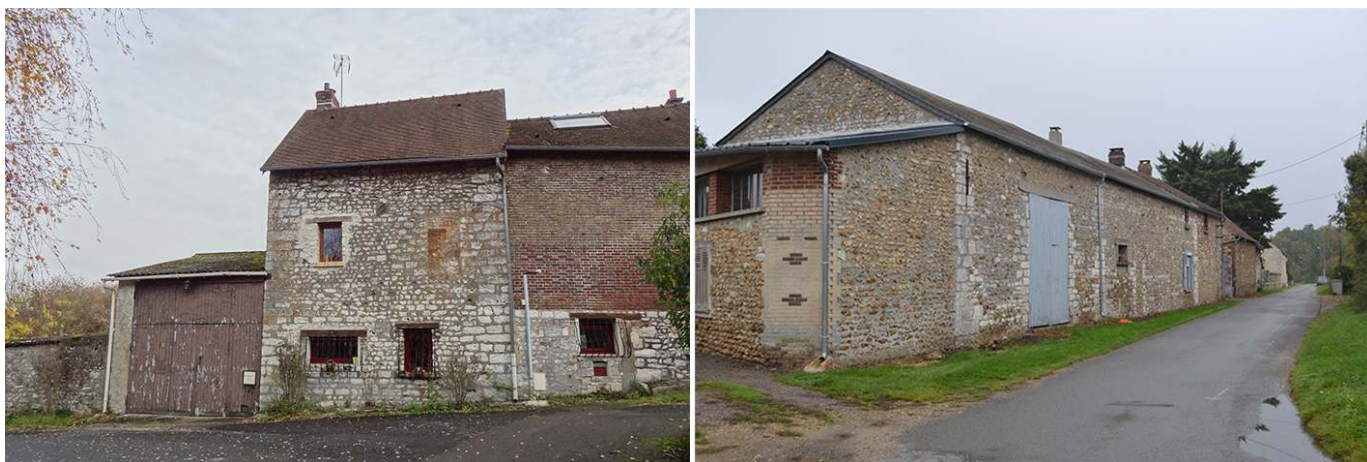
exemples de maçonneries locales
